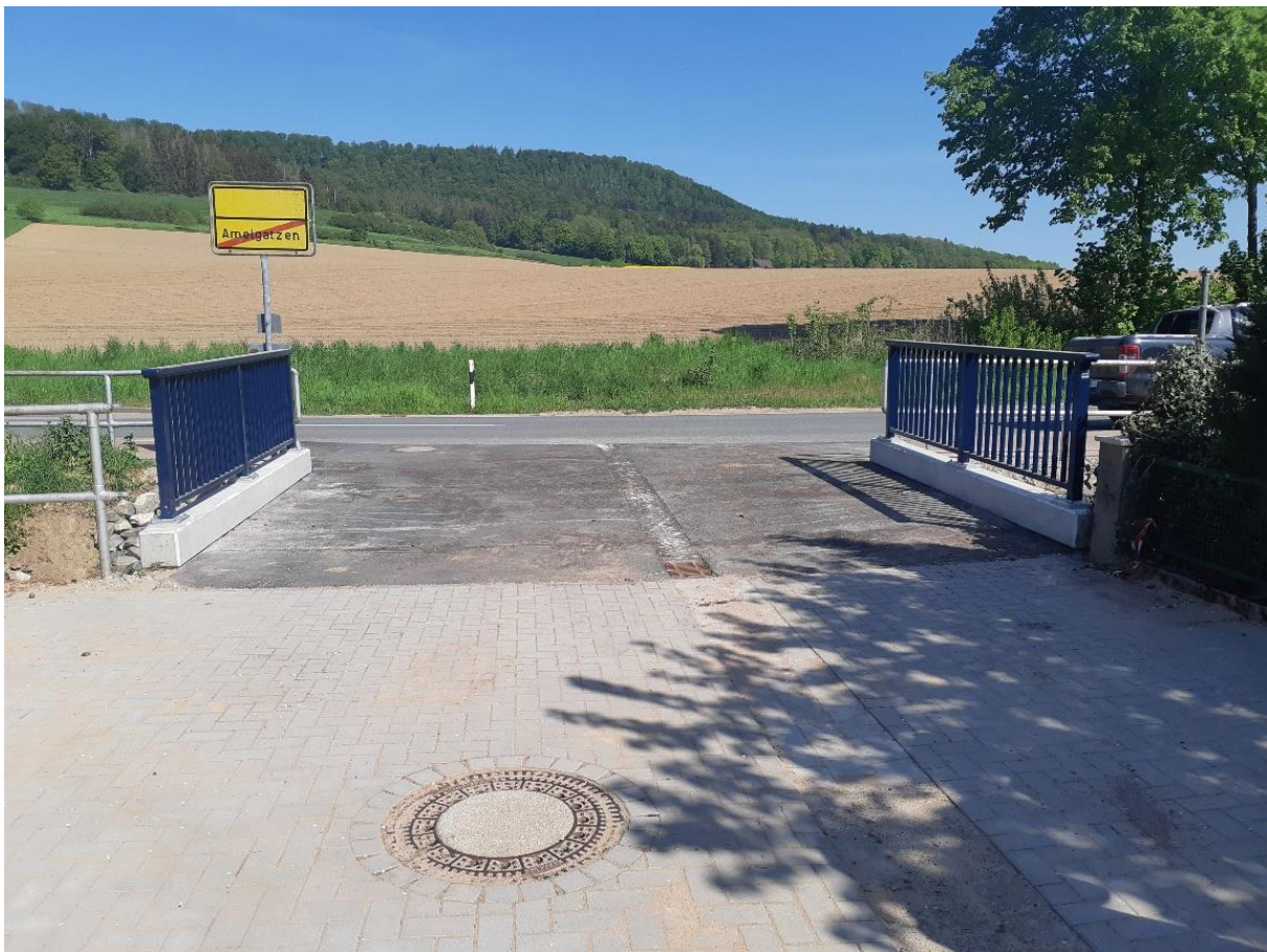
Neue Brücke Schlesierweg in Amelgatzen
