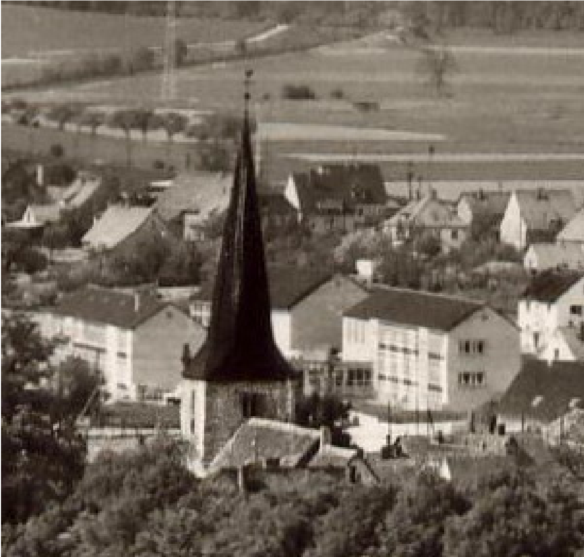
Schule (heute Grundschule) und Turnhalle (heute Kultur[n]halle) auf einem Foto von 1964 468
