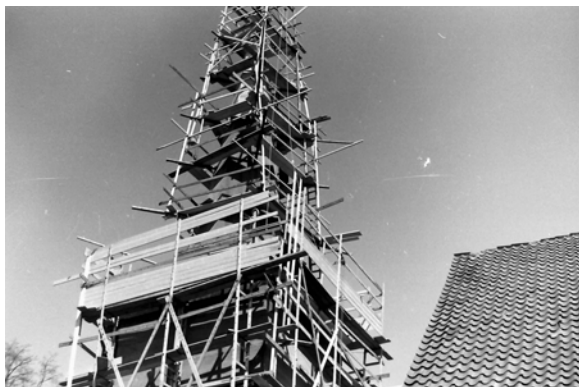
Neueindeckung des Kirchturmes 1974
