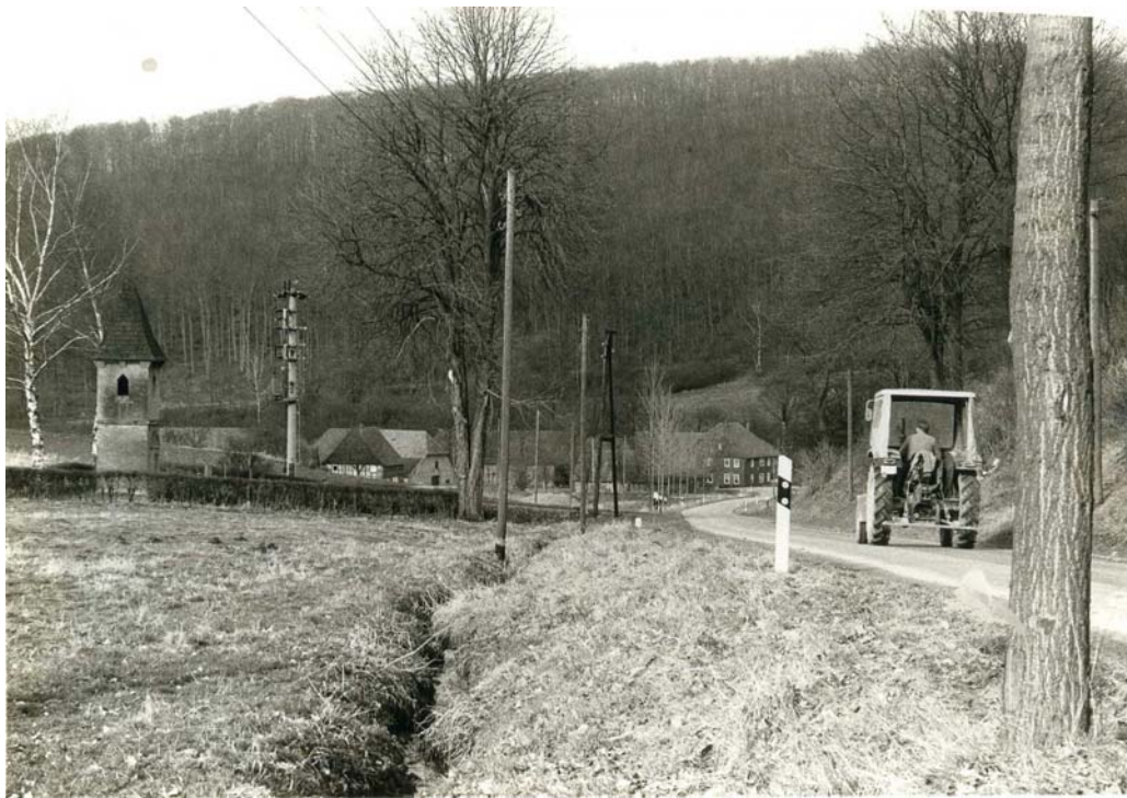
Blick auf Deitlevsen, links der Friedhof mit Glockenturm 1301
