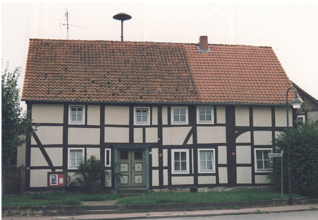
Die ehemalige Frenker Schule in der Neuzeit 289
