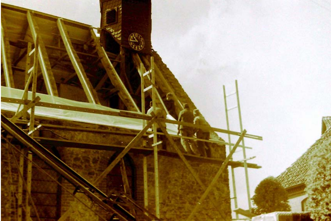
St.-Johannis-Kirche zu Frenke, Dacharbeiten 1975 1111
