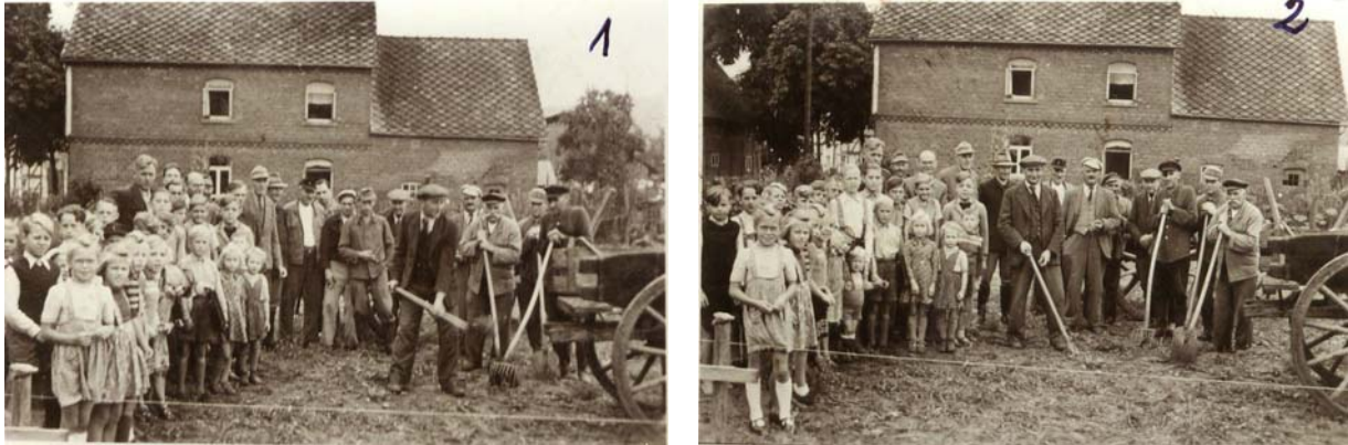
Die neue Schule für Latferde – erster Spatenstich ... 520
