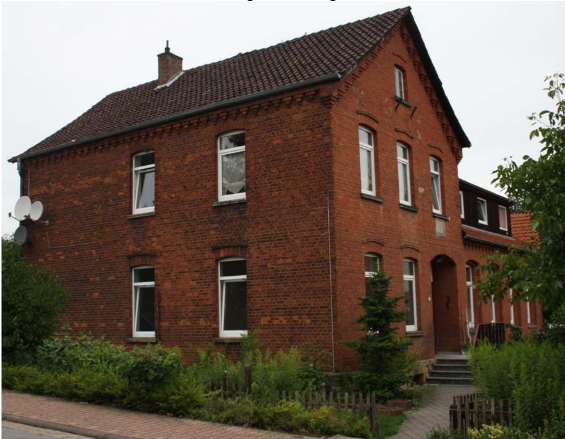
Ehemalige Schule in Amelgatzen von 1885 84
