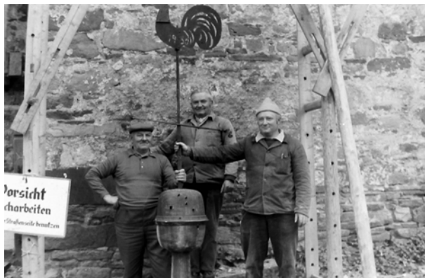
Ausführungen der Arbeiten durch Dachdeckerbetrieb Mönkemeier, Frenke; deutlich erkennbar: die durch Schüsse durchlöcherter Kugel 722
