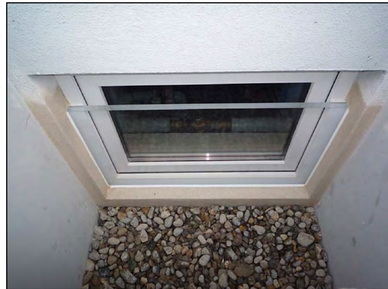
Objektschutz: Wasserdichte Vorsatzscheibe (Tafel)
