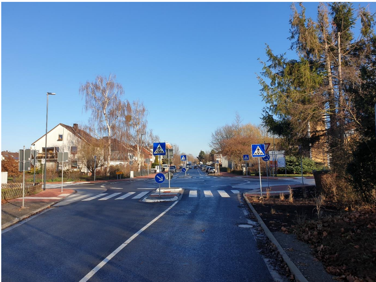
Berliner Straße nach der Sanierung
